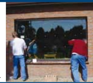
Vervanging van enkel glas door hoogrendementsglas.
