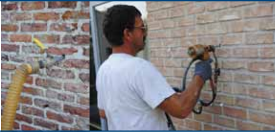
Isolatie inspuiten in de spouw.
